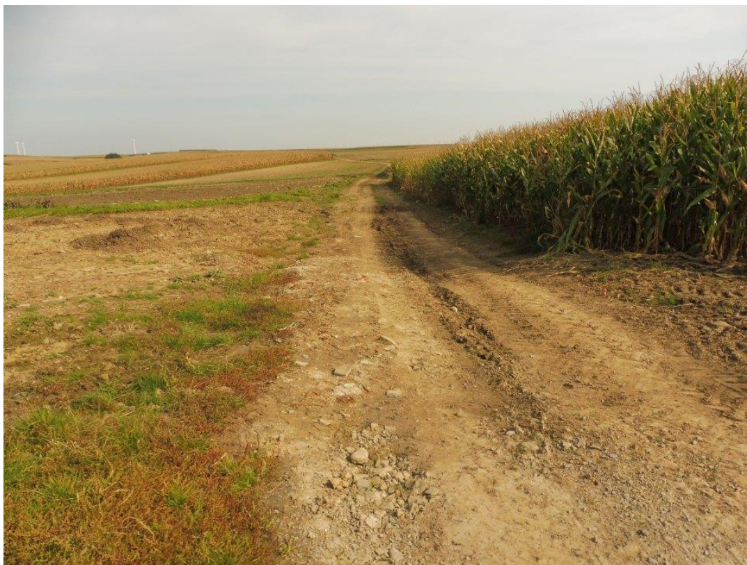
Rysunek 14. Przebudowa drogi dojazdowej do gruntów rolnych w obrębie Markowa dz. o nr ewid. 29
