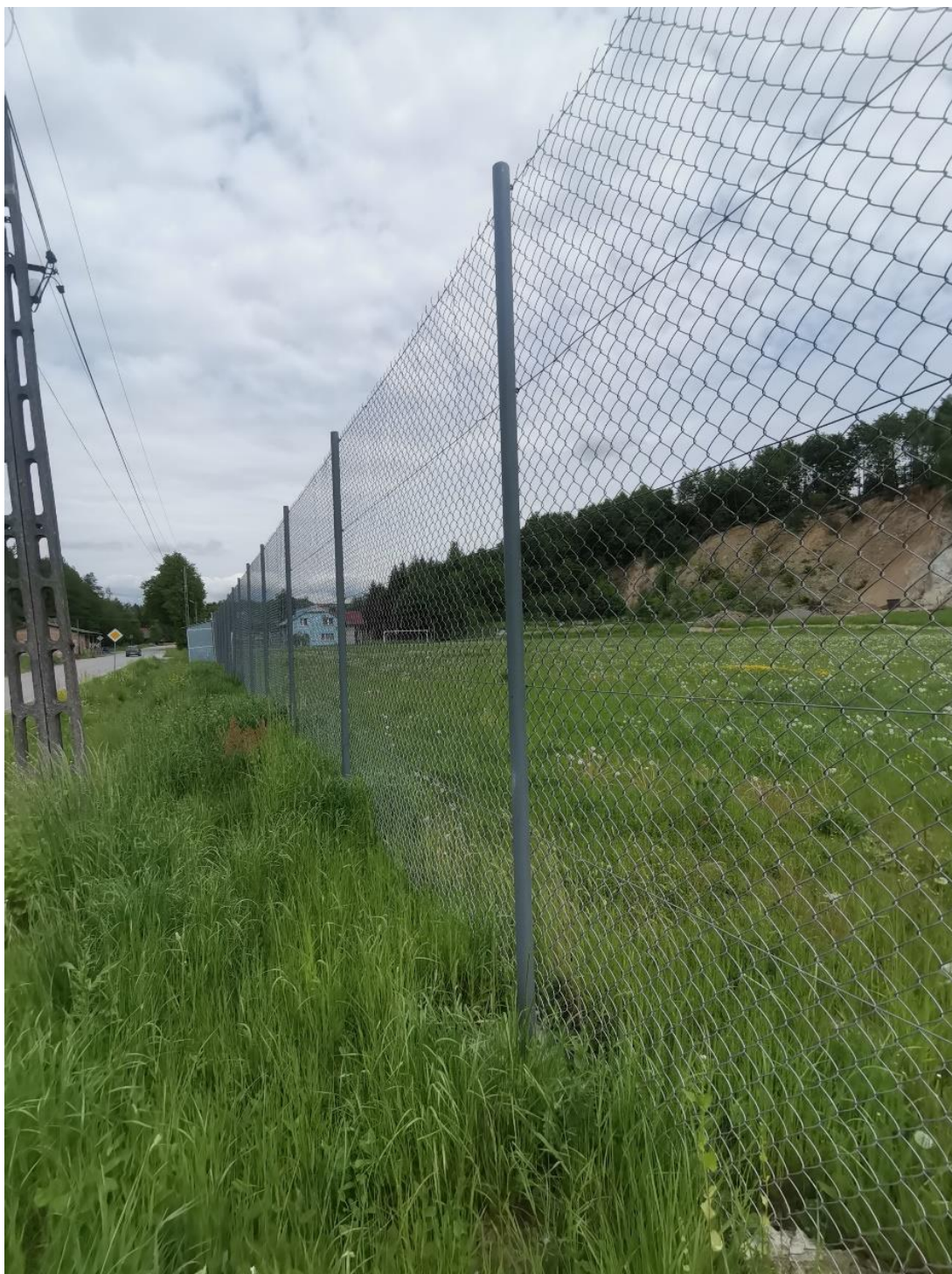
Rysunek 16. Odbudowa ogrodzenia boiska w Tarnawce
